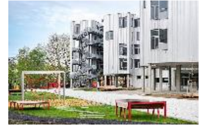
Gymnasium und ISS Allee der Kosmonauten Fertigstellung Frühjahr 2024
